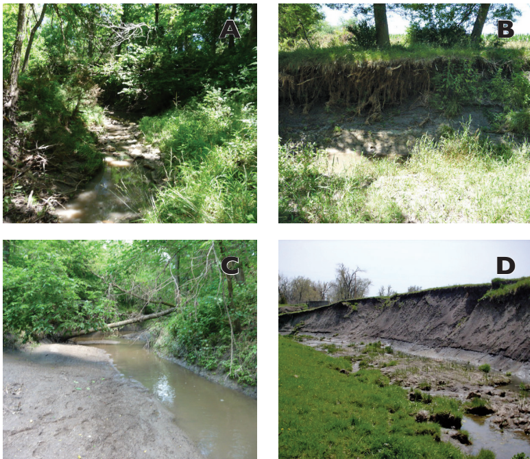
Figure 11. Atchison County Site Photos: (a) Site 1, (b) Site 2, (c) Site 3, and (d) Site 5.
